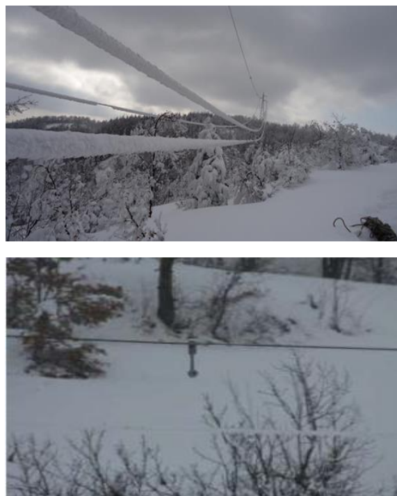
Figura 29 Manicotto di ghiaccio su conduttore (in alto) e dispositivo anti-rotazionale (in basso).
