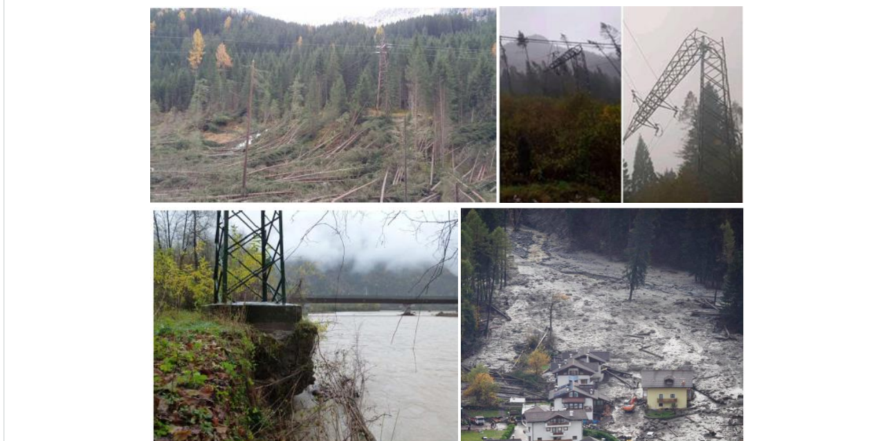
Figura 25 I danni della perturbazione del 29 Ottobre 2018 nel Triveneto.
